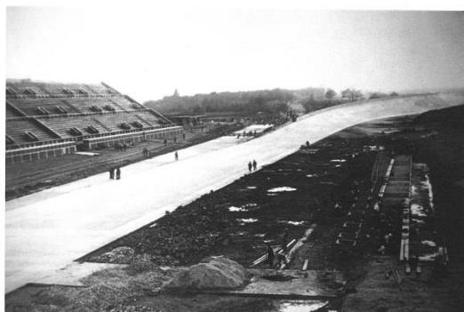
Raccordement du circuit routier en construction avec l'anneau de vitesse devant les tribunes, 17 avril 1925 (archives Automobile Club de France)
